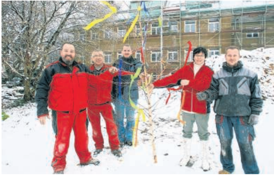
Rechtstef für das Mehrgenerationenhaus in Wachau: Geschäftsführerin Anke Kemsies mit den Bauleuten. Foto: André Kempner
