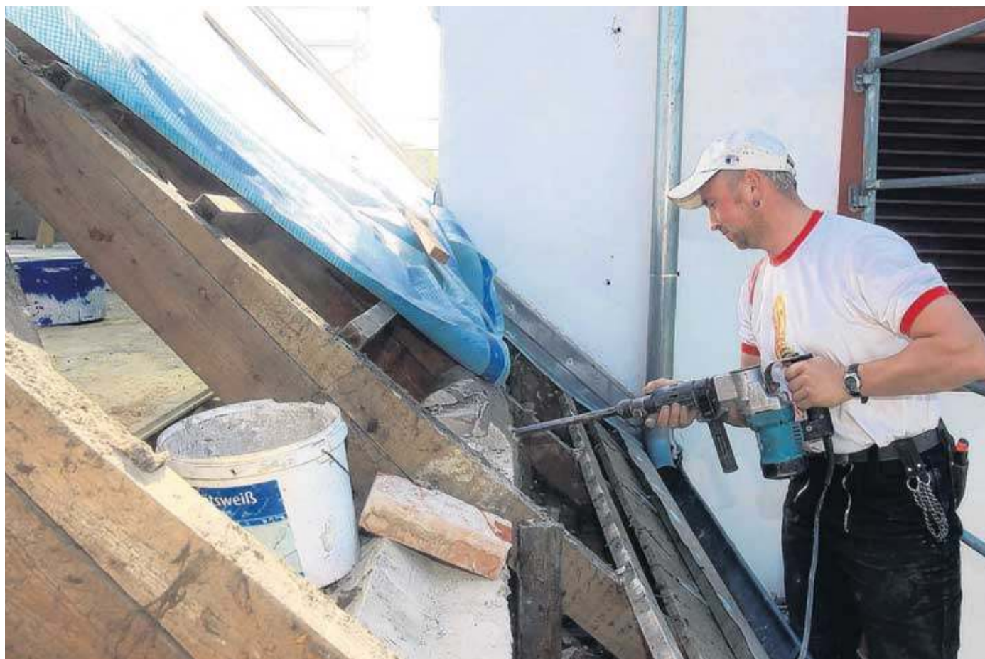
Sven Naumann vom Bad Lausicker Unternehmen Lipfert Bedachungen legt die Schwelle frei für die Dachhinterlüftung. Foto: Taubert
